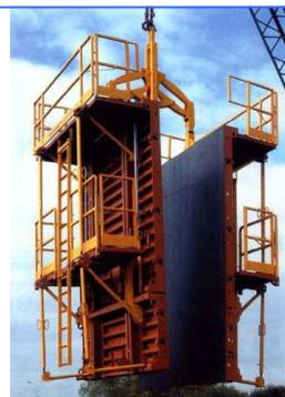
Figure 15 : Paire de banches entre lesquelles va être coulé le béton.
