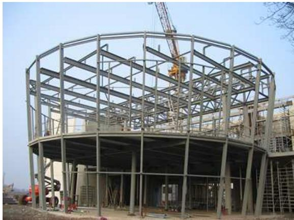
Pour certains édifices, le choix d'une charpente métallique a l'avantage de réduire les charges transmises au sol par comparaison avec des éléments porteurs en béton.
