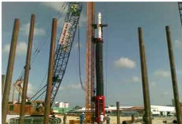
Figure 16 : Mise en place d'une jupe acoustique sur le mât de battage.
