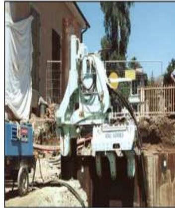
Figure 14 : Principe de fonctionnement du vérin hydraulique pour l'enfoncement de palplanches.
