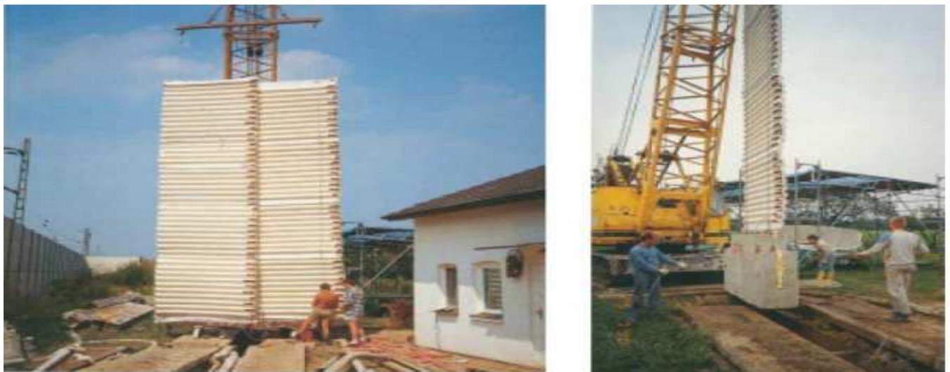
Figure 23 : Technique d'isolation par tranchée remplie par un rideau de couches de gaz (AL ABDEH, 2005).
