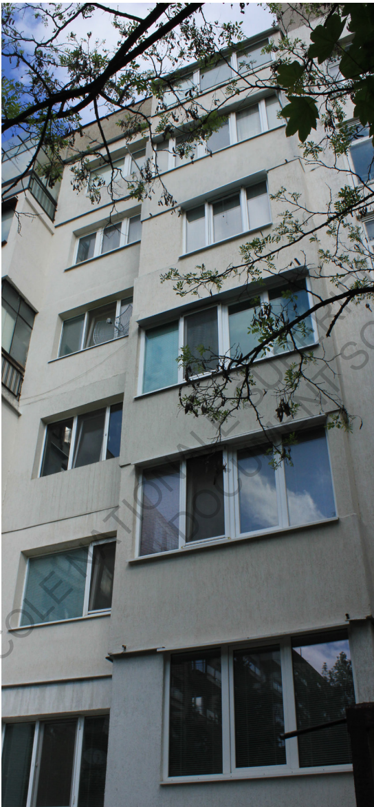
Fig.38 : Mladost 2 : L'uniformité de la façade de cette cage d'escalier est la preuve d'un consensus entre les habitants concernant la réhabilitation de l'ensemble de la barre : toute l'isolation a été refaite simultanément
