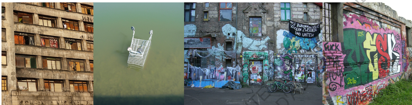
La dégradation progressive,
