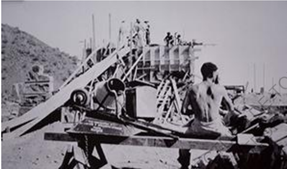
Fig. 30 Le coffrage du mur de pierre et béton.
