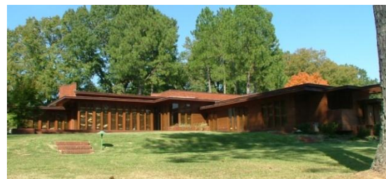
Fig. 12 Le jardin marqué par la forme en L du bâtiment, s'ouvre largement sur cet espace intime.
