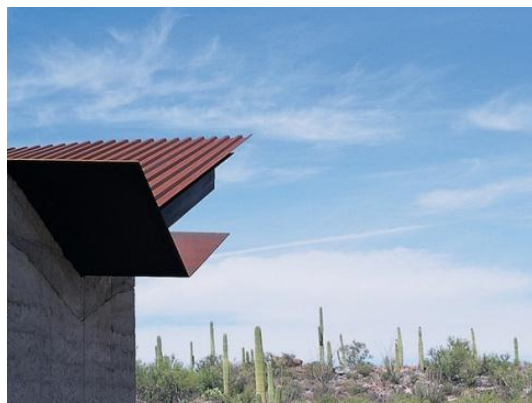
Fig. 39 Le porte à faux de la toiture en métal accentue la légèreté. Photo : Bill Timmerman
