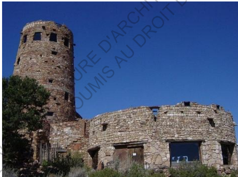
Fig. 03 Vue d'ensemble de la tour avec sa partie haute et sa partie basse.
