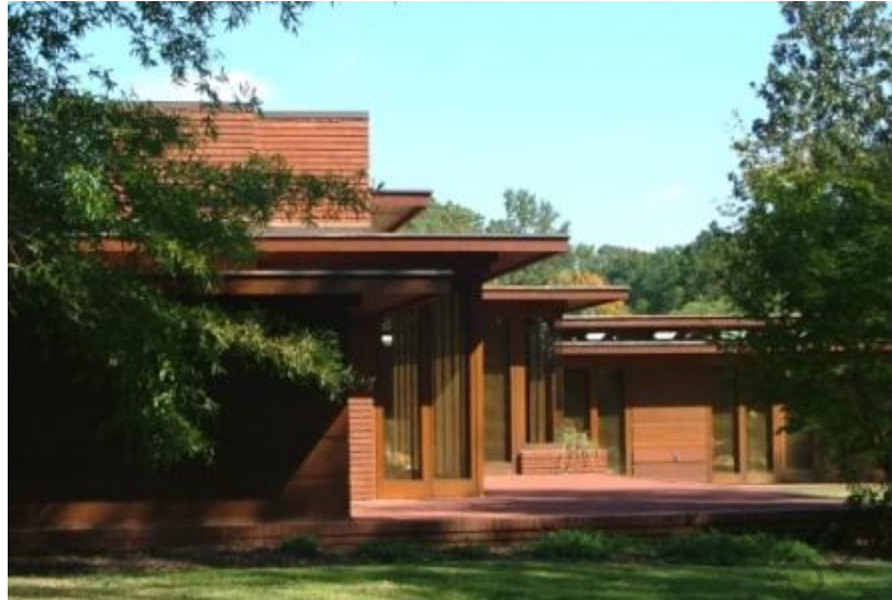
Fig. 14 Le prolongement de la toiture en porte à faux.
