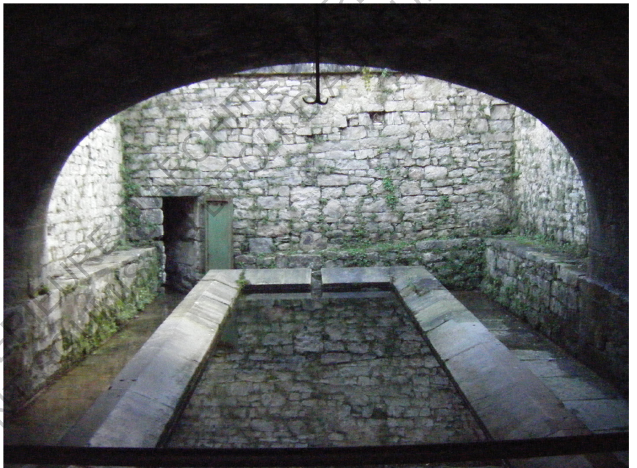
Vue de l'intérieur
