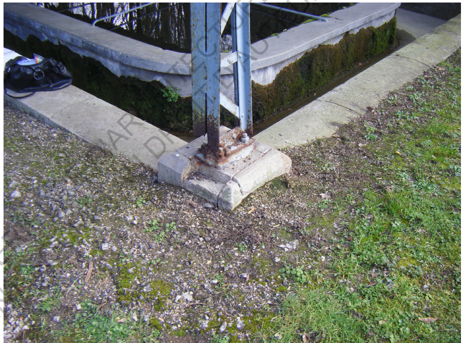
Pied d'un poteau
