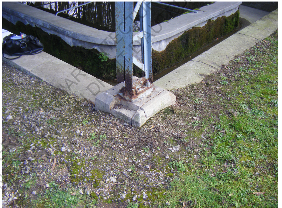
Pied d'un poteau
