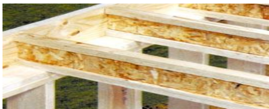
Figure 2.2.5.1.7: Exemple de poutres composites en I (solivages de plancher et pannes)
