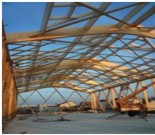
Figure 2.2.5.1.3 : Le bois lamellé-collé libère les formes architecturales grâce à sa modularité
