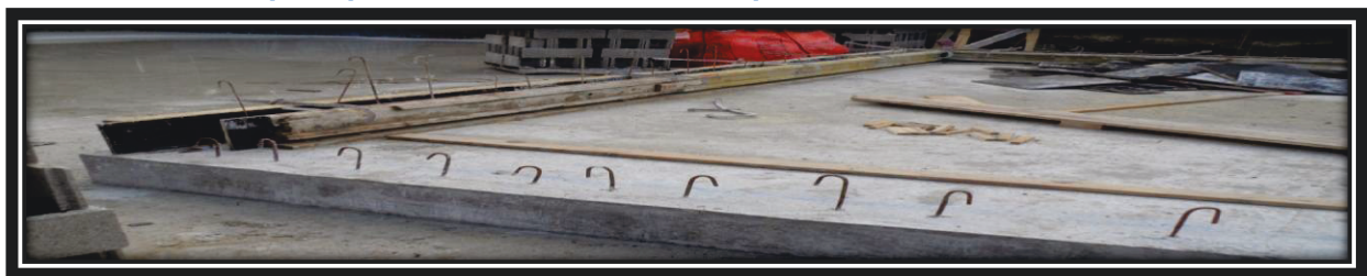
Photo : 2.6.1.1c : réalisation des talonnettes en BA. Désolidarisation sol (jardin)/bois
