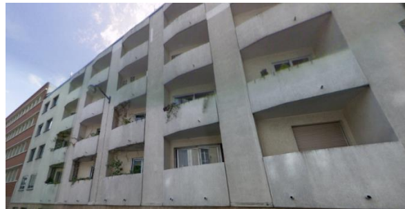
Figure 32 Rue du Père Coirentin - Photographie
