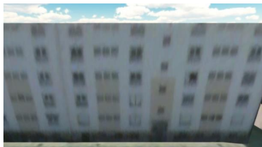
Illustration 8 : Bâtiment trop bas : texture coupée à travers les fenêtres du dernier étage
