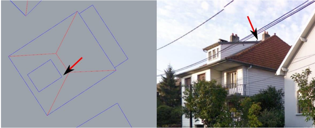
Illustration 9 : Exemple de point considéré comme altitude maximale de la ligne de toiture (cas de la lucarne rampante), source de l'image : streetview
