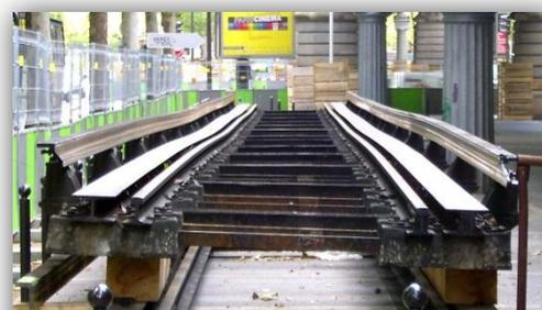
Figure 3 : coupe d'une voie de métro pneumatique (source : <http://emdx.org/rail/metro/principe.php>)
