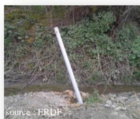
**Figure 45 : illustration de non verticalité des fourreaux**
