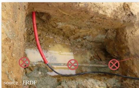
**Figure 23 : Illustration des 3 points à lever en fouille ouverte**
