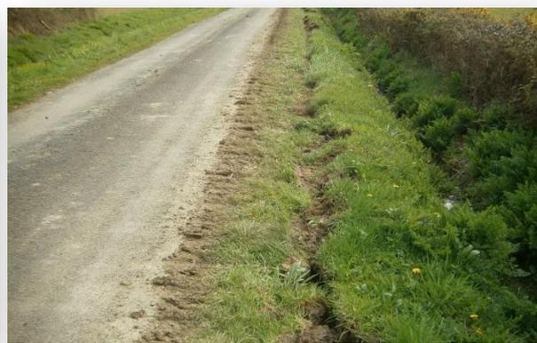
Figure 33 : Restes du passage du sous-soleur
