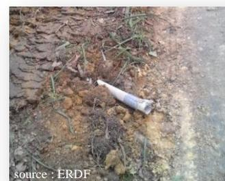
**Figure 47 : Illustration du caractère accidentogène des fourreaux**
