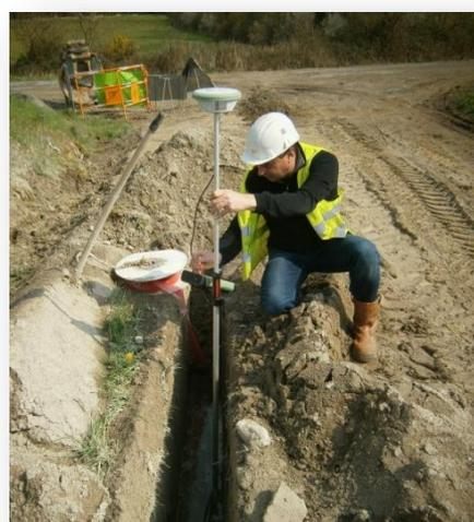
Figure 37 : récolement ouvrage posé en trancheuse
