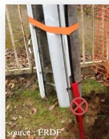
**Figure 22: illustration de levé d'une remontée aéro-souterraine**
