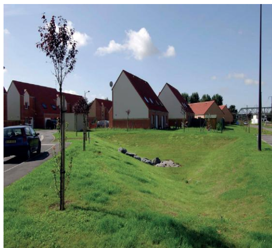
Figure 3: Bassin de stockage en eau - lac du Château, Villeneuve d'Ascq (Gauche) et Bassin sec enherbé – rue de Carpentras, Sequedin (Droite) (Source : Guide de gestion des eaux pluviales Lille Métropole Fiche n°4 Les bassins,2012)
