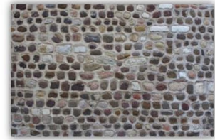
Image servant de test à notre outil de segmentation et de classification automatique : Mur de la cathédrale du MANS
