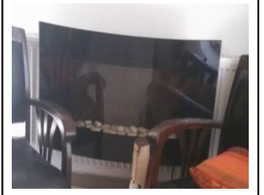
Photo 12 : Radiateur électrique d'appoint posé sur un radiateur défectueux
