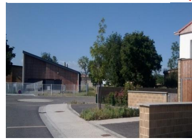
Photo 3 : Chaufferie du Chandelet
