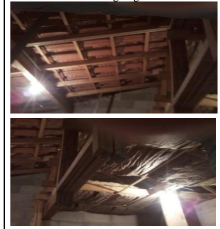
Photo 6 : Toitures des garages mal isolées
