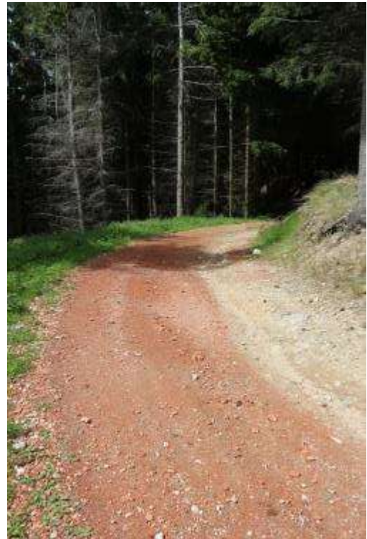
Figure 23: Dépôt de tuile pour empierrer la route
