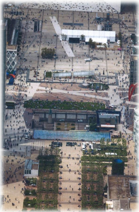
Illustration n°5: Dans le quartier de La Défense, la présence d'EIC impose que des servitudes de passage doivent être établies pour permettre le déplacement des piétons sur la dalle.
