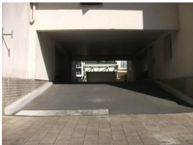
Figure 15 : Ressaut à l'entrée du parking (source : A. Moreau)
