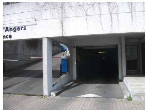
Figure 7 : Entrée de parkings en rez-de-chaussée (source : A. Moreau)
