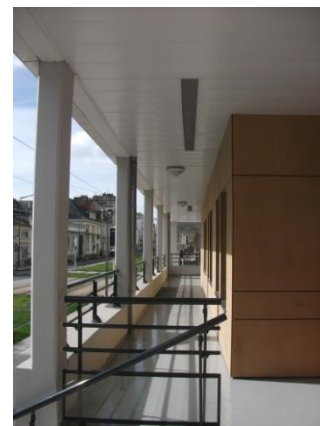
Figure 13 : Succession de coursives surélevées (source : A. Moreau)
