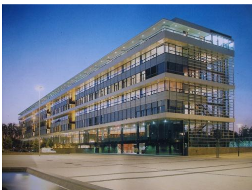
Figure 11 : Le long bâtiment de la CNP (source : cabinet Dusapin)
