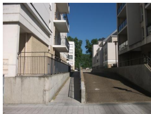
Figure 17 : Rampe pour handicapés et ressaut d'entrée de parkings (source : A. Moreau)
