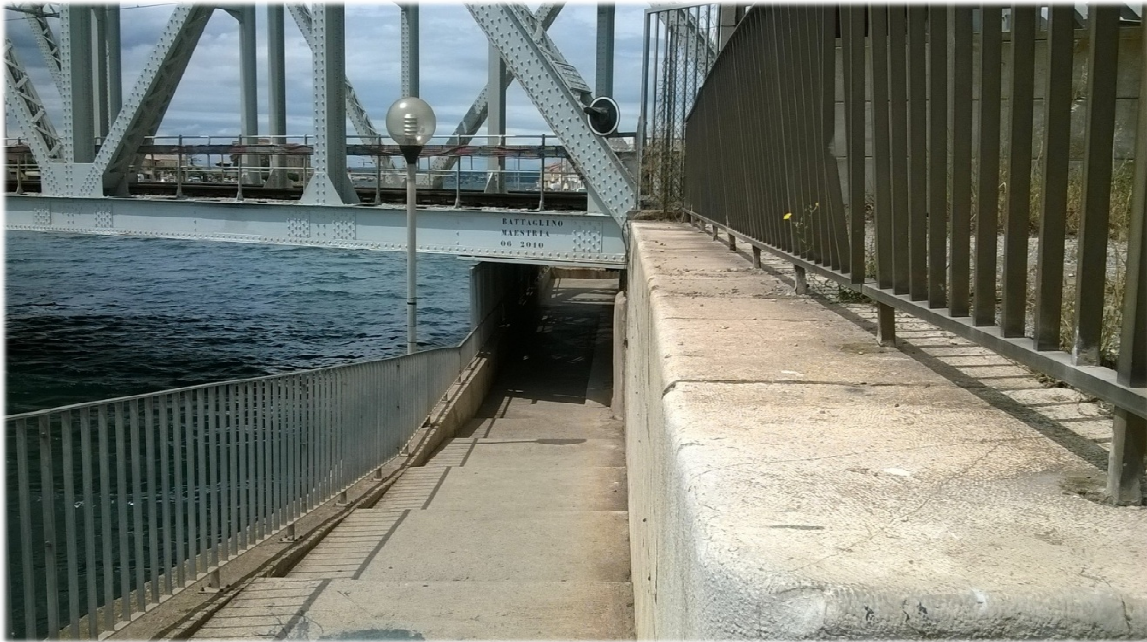
Figure 14 : Cheminement piéton sous le pont-rail Maréchal Foch
