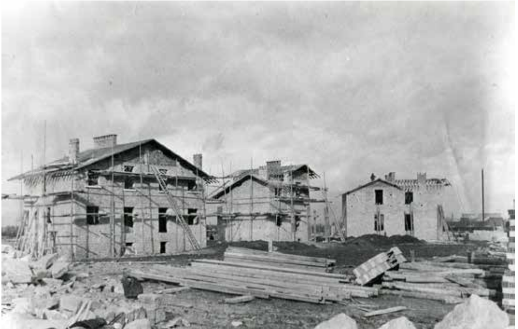
La Cité-jardin Maison-Blanche en chantier entre 1928 et 1930.
