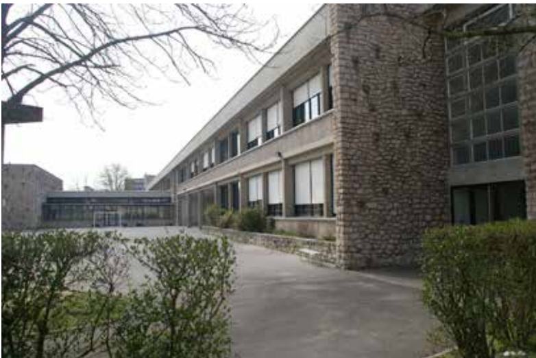
Entrée du collège des Trois-Fontaines bd Charles-Arnould et sa façade arrière.
