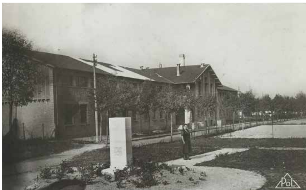
L'école primaire Maison-Blanche quelques années après sa construction.
