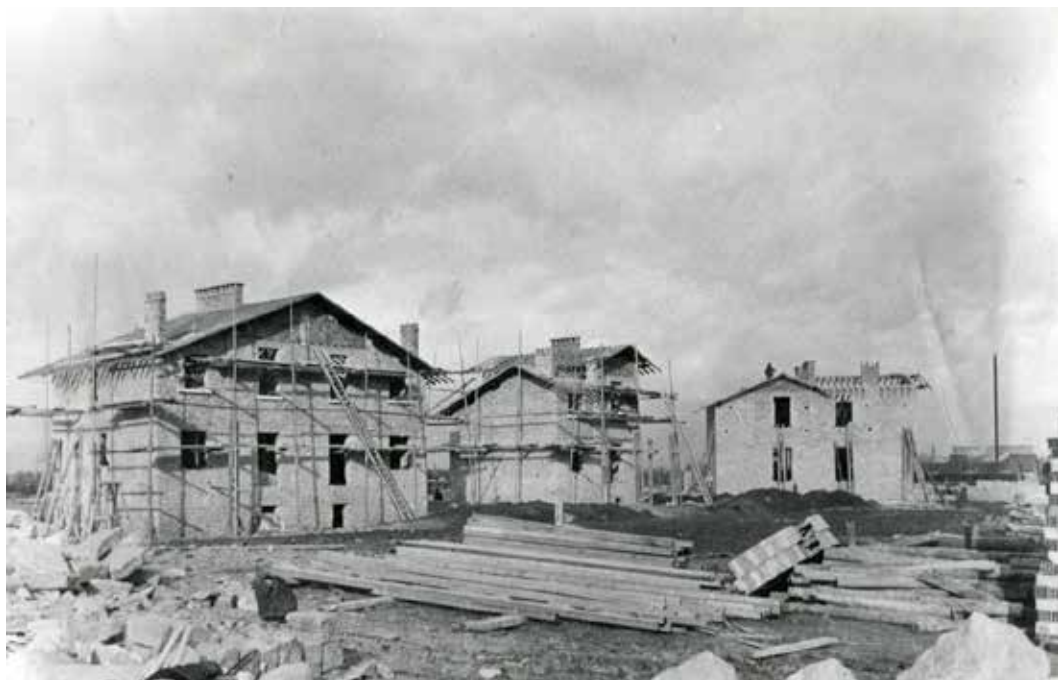
La Cité-jardin Maison-Blanche en chantier entre 1928 et 1930.
