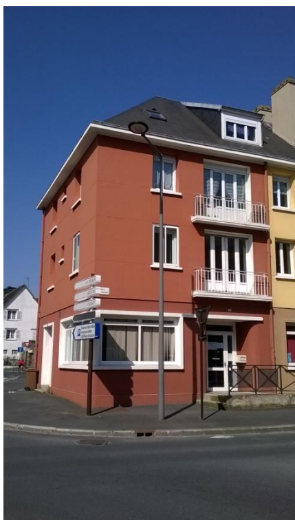
L'ancien CAMSP (uniquement le rez-de-chaussée et le premier étage)
