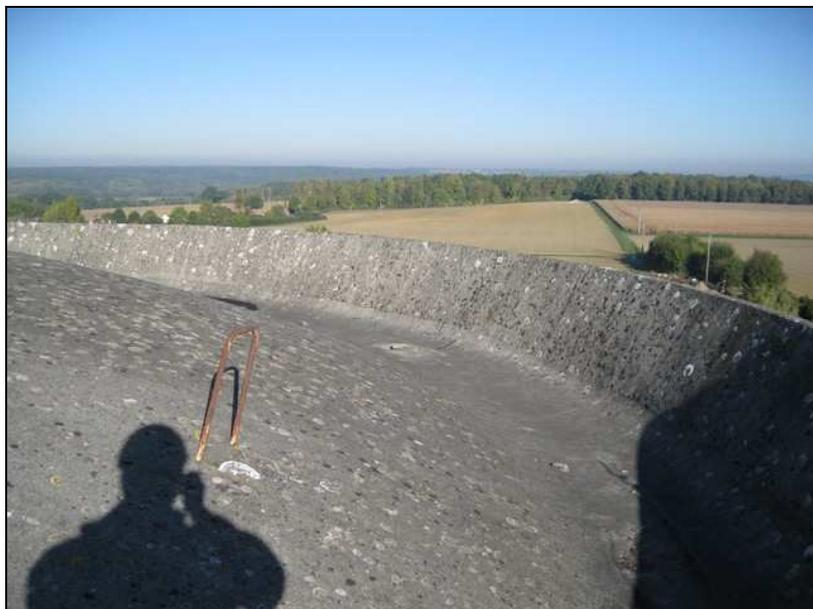
Photo 46 - Absence de garde-corps sur la toiture
