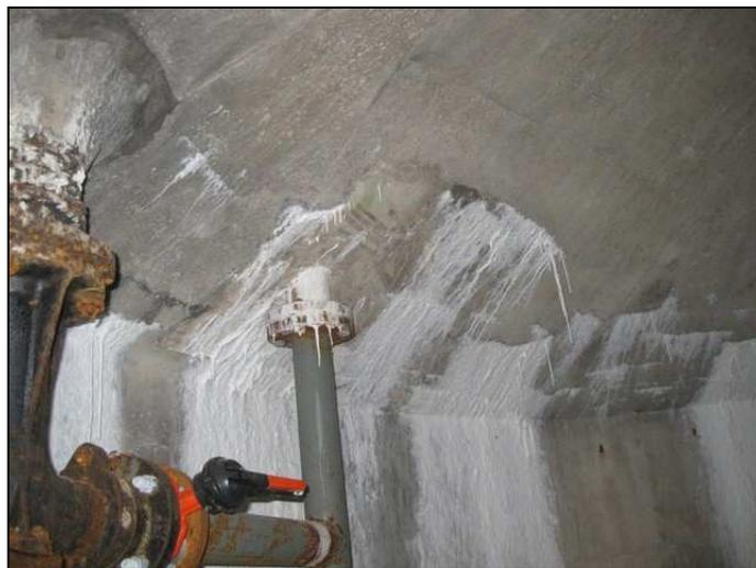
Photo 37 - Efflorescences en sous-face de cuve
