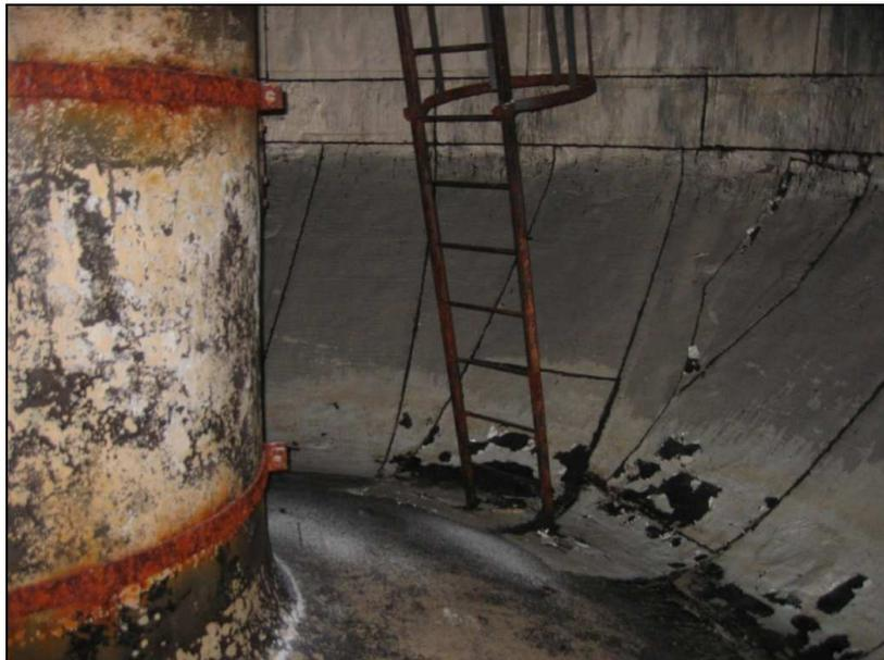
Photo 43 - Décollement d'une étanchéité de type membrane bitumineuse
