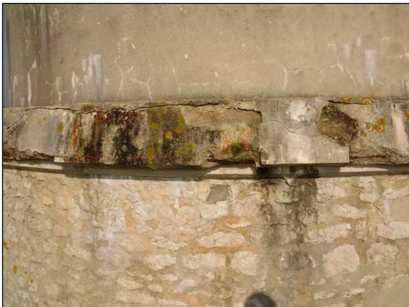
Photo 38 - Eclat et fissuration sur la ceinture basse
