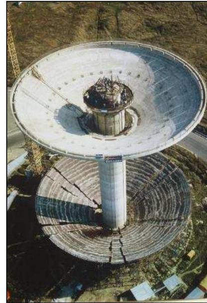
Photo 23 - Levée de la cuve par câbles
