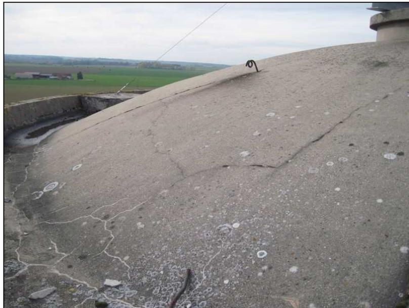
Photo 35 -Fissuration de l'enduit sur coupole
