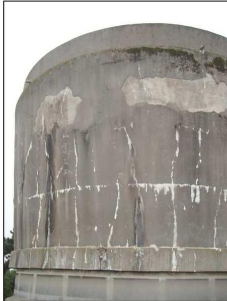
Photo 33 - Fissures verticales et horizontales
