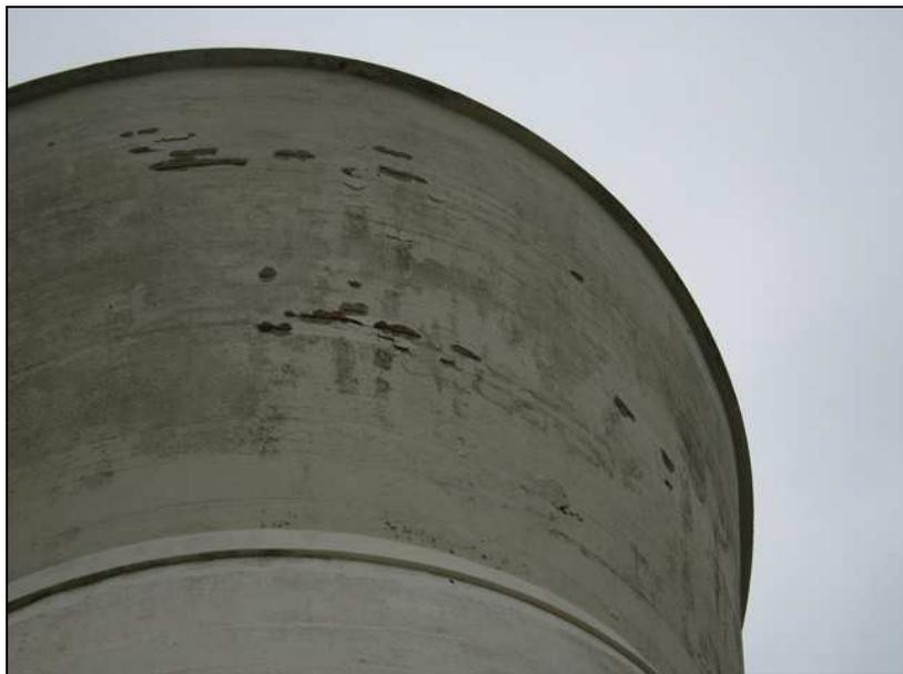
Photo 26 - Aciers apparents et corrodés sur cuve
