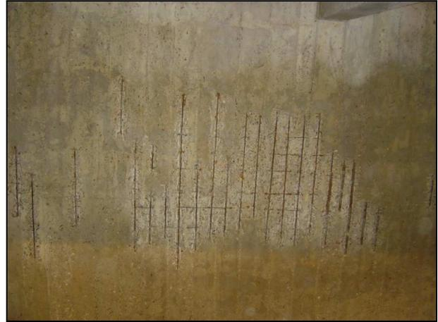
Photo 28 - Aciers corrodés en sous-face de cuve
