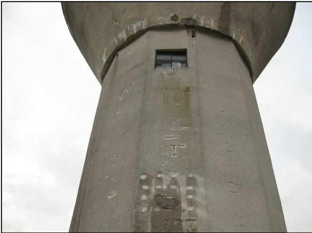
Photo 24 - Aciers apparents et corrodés sur fût
