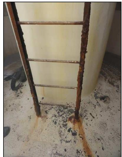
Photo 44 - Corrosion de l'échelle intérieure
