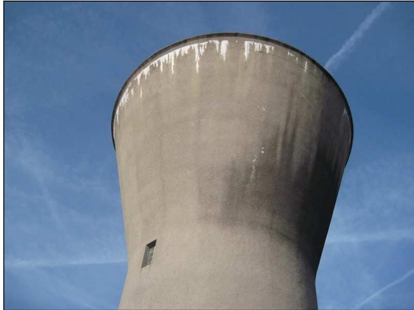
Photo 31 - Fissure horizontale sous la ceinture haute
