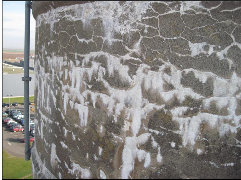
Photo 30 - Fissures et efflorescences sur la cuve
