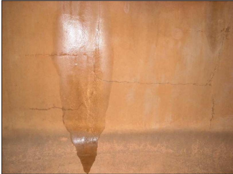
Photo 42 - Fissuration d'une étanchéité de type enduit hydraulique
