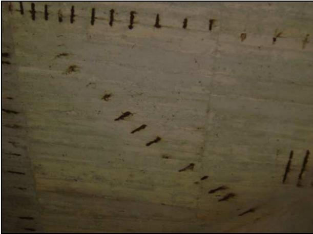
Photo 27 - Aciers corrodés en sous-face de cuve
