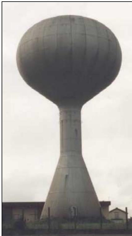
*Photo 15 - Réservoir sphéroïdale*
