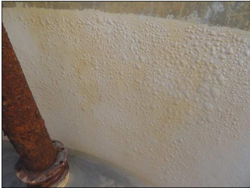
Photo 41 - Cloquage d'une étanchéité polyuréthane
