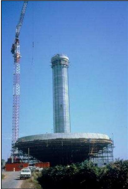
Photo 22 - Coffrage au sol de la cuve
