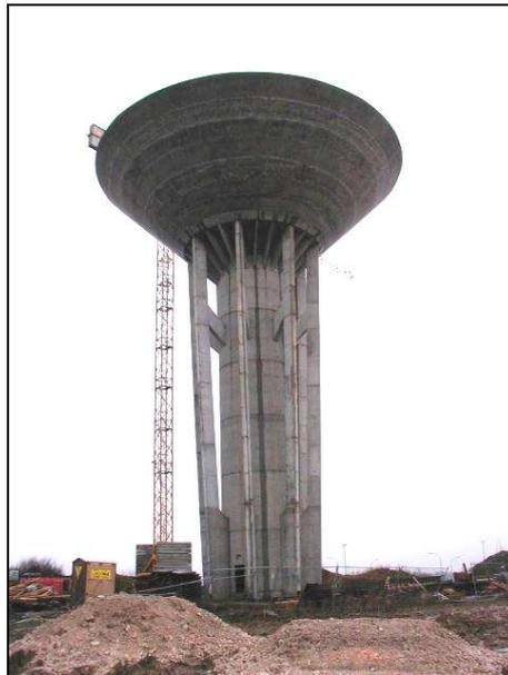
Photo 21 - Réalisation de la cuve
