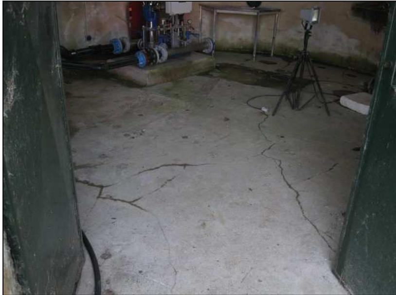
Photo 29 - Fissuration de la dalle du plancher bas du fût, due à des remontées d'eau du sol
