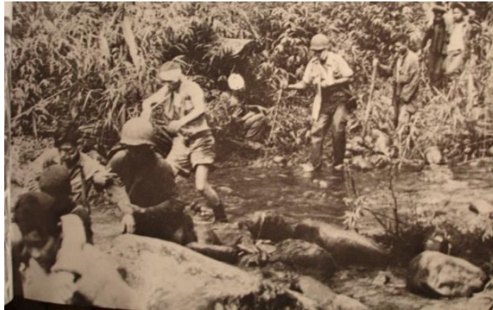
Figure 21: Evacuation des blessés, descente du cours de la Nam Muoi
