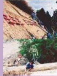
> Mise du chaume à Kerguan (Source : M. Lévy)
