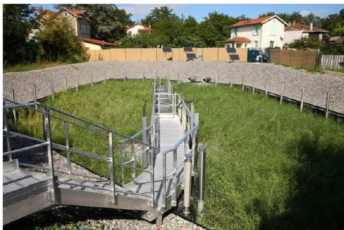
Séparation du filtre et niveaux de connexion hydraulique
