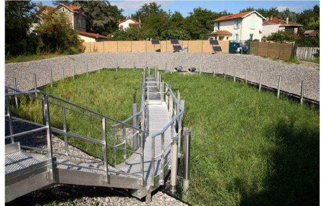
Figure 19 : Dispositif gabions anti-affouillement pour les gros débits et filtre à deux bassins avec une grande capacité de stockage (SEGTEUP. 2013)
