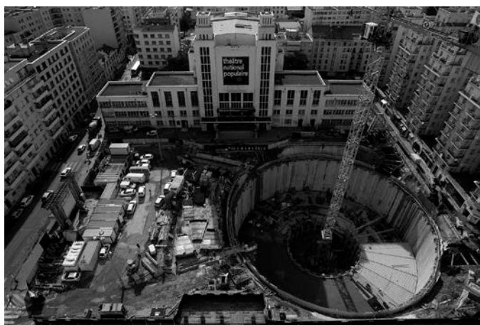
La place Lazare-Goujon en travaux © Christian Ganet
