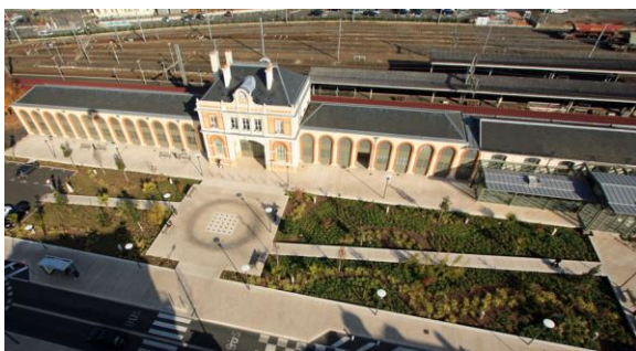
Fig. 20 : Vue aérienne du parvis de la gare de Vichy (Photo : www.citearchitecture.fr )
