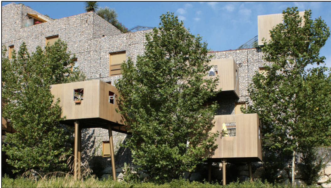
Figure 33 - L'immeuble qui pousse, Edouard François Source : http://www.edouardfrancois.com
