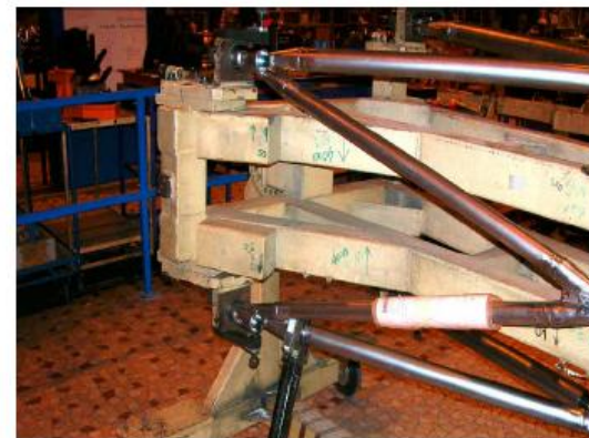
12 ème soudure : Position de départ du bâti à 90°
