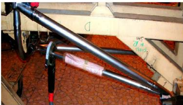
5 ème soudure : Position de départ du bâti à 180°
