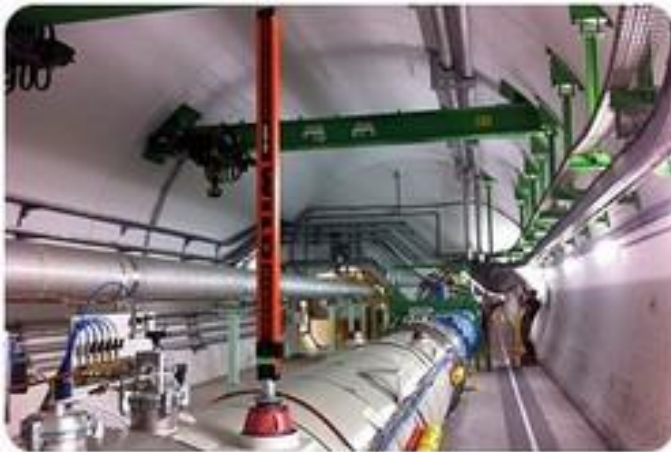
Figure 5 : Mesure de nivellement sur un dipôle du LHC
