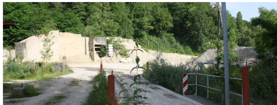
Fig12. Entrée du site des Granges - Source : Agence ARTER
