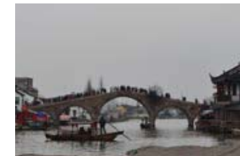
Le plus vieux pont de Zhujiajiao date de la dynastie Qing
