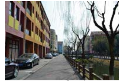
Les logements collectifs de hauteur R+3
