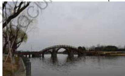
Nouveau pont inspiré de la forme de l'ancien
