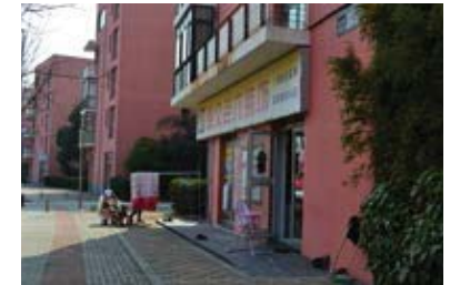
On y trouve les commerces au rez-de-chaussée
