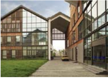
Vue depuis la cour intérieur du centre administratif
