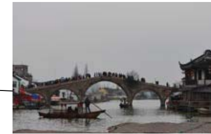
Le plus vieux pont de Zhujiajiao, en pierre de 70m de long, date de 1571
