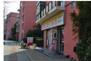
On y trouve le commerce au rez-de-chausée
