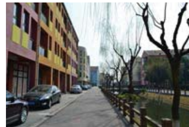
Les logements collectifs de hauteur de R+3
