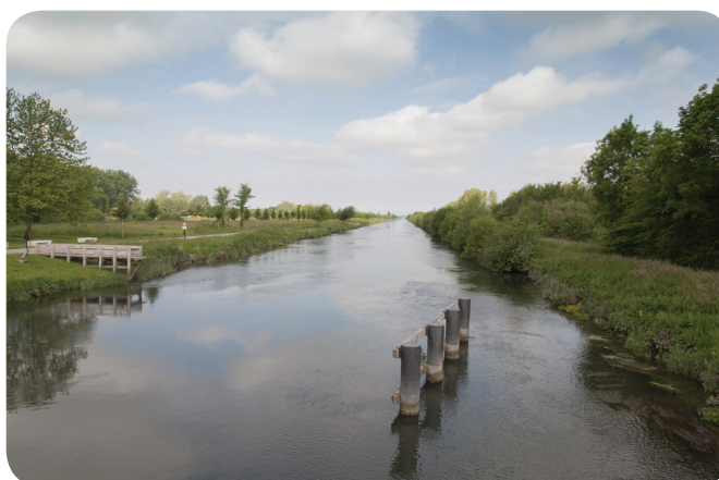
Figure 7. Canalisation de la Somme à Petit-Port. Photo 17 0018 05 de l'OPP PM, 2015. (Isaline Soller, DREAL Picardie).
