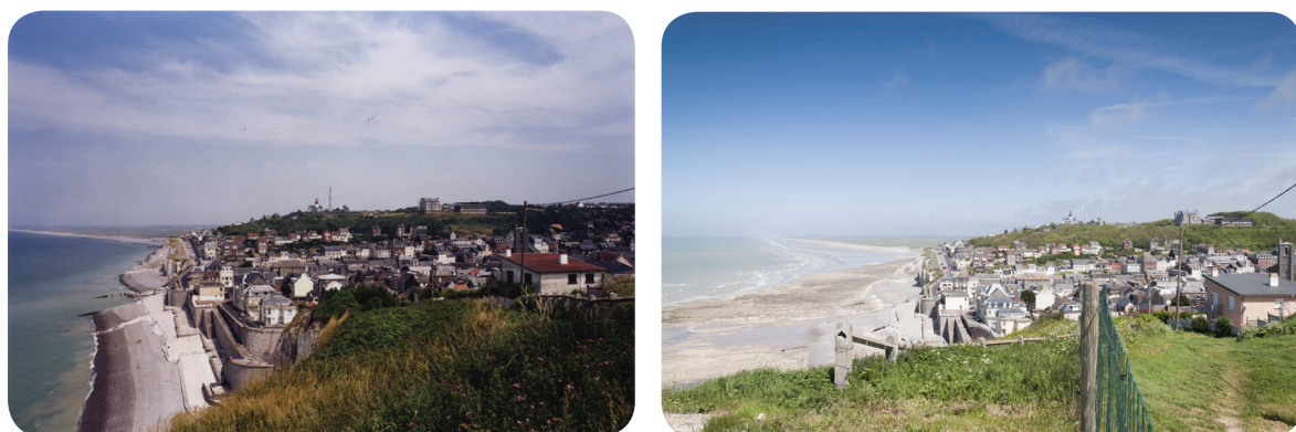
Figure 22. Illustration de la dynamique de recul de la falaise vive dans l'unité «Falaises vives et valleuses ». Photo 17 0004 01 (gauche) et 17 0004 05 (droite). On observe le recul du point de vue avec le recul de la falaise. La barrière à droite de l'image en 2002 (17 0004 01) passe à gauche de l'image en 2015 (17 0004 05) (Fred Boucher, Isaline Soller, DREAL Picardie).
