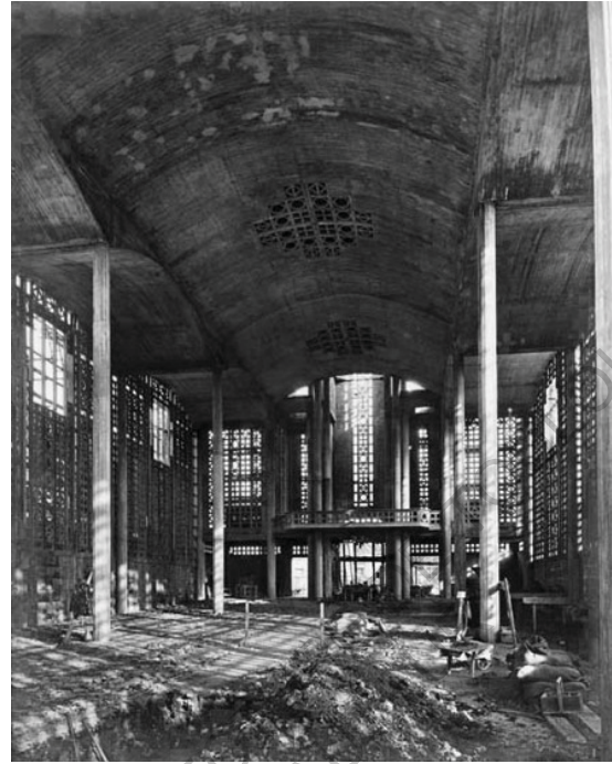
Illustration 16 - Antérieur de la nef vers le narthex en fin de chantier
