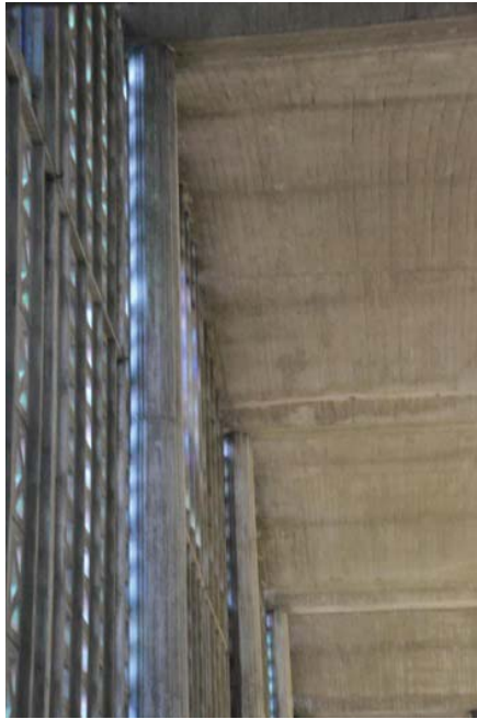
Illustrations 47 – détail de l'enveloppe détachée de la structure
