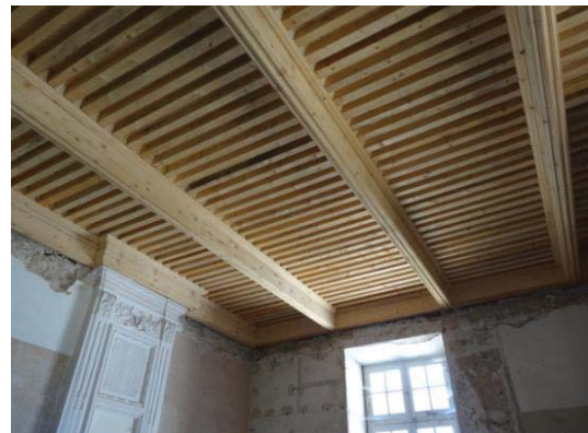
Figures 20 et 21 : Plafond à la française du vestibule (à gauche) - Plafond à la française restauré (à droite).
