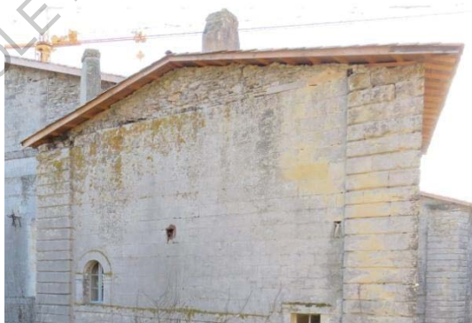
Figures 26 et 27 : Remplissage du pignon – Amorce d'ouvertures (soubassement visible).
