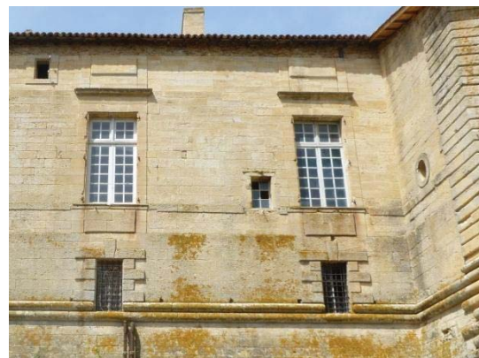
Figures 26 et 27 : Remplissage du pignon – Amorce d'ouvertures (soubassement visible).
