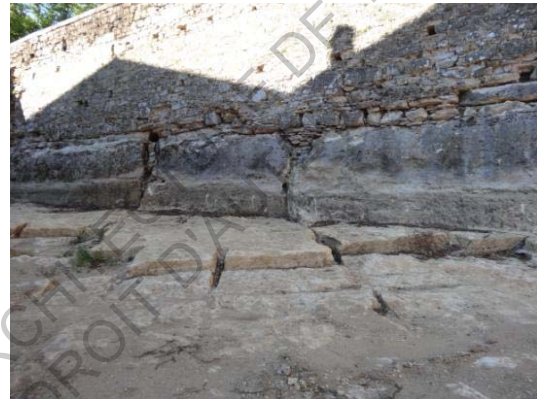
Figures 18 et 19 : Fondations sur la roche (à gauche) - Traces de carrière de pierre (à droite).
