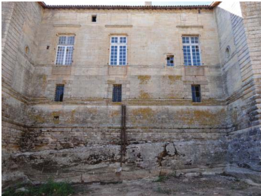
Figures 18 et 19 : Fondations sur la roche (à gauche) - Traces de carrière de pierre (à droite).
