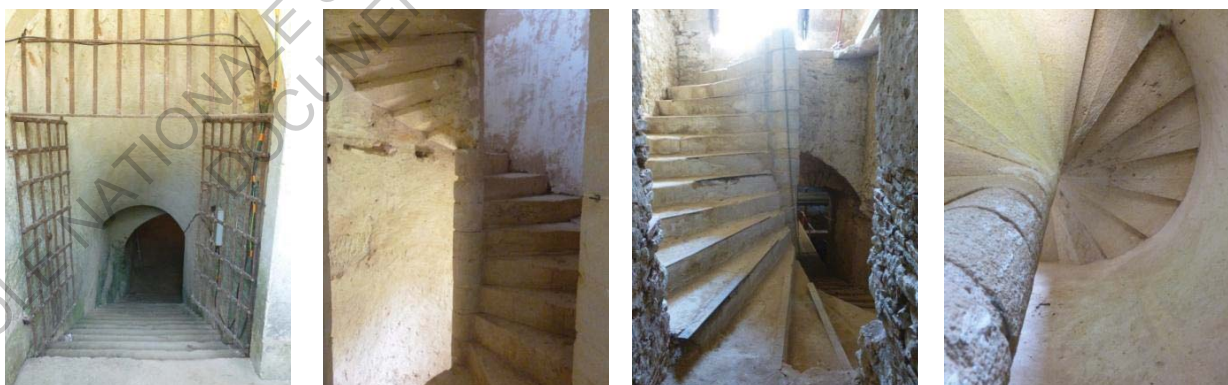
Figure 72 : Divers escaliers du château de Ferrals.
