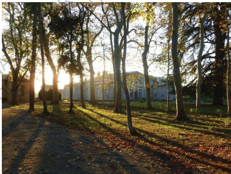
Figure 37 : Façade Nord vue du parc
