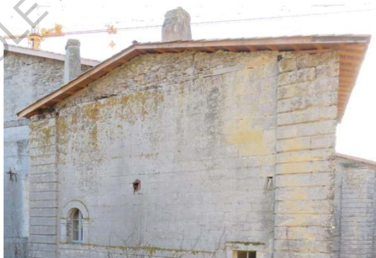
Figures 26 et 27 : Remplissage du pignon – Amorce d'ouvertures (soubassement visible).
