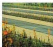
Traitement de la voirie
