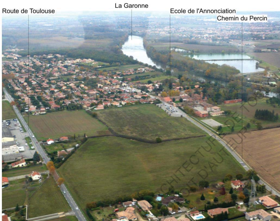
Figure 13 Vue aérienne du site Laubis depuis le Sud (source : Document de la concertation préalable à la création de la ZAC, Toulouse Métropole)
