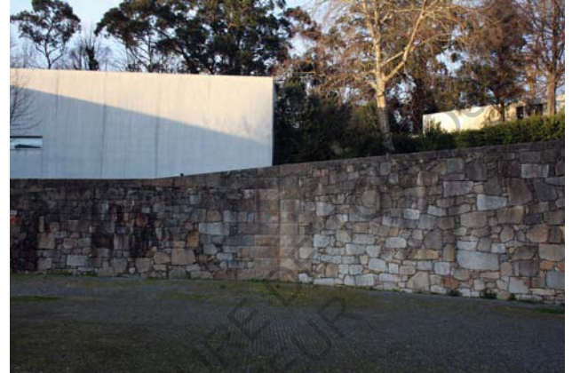
Enduit et granit
