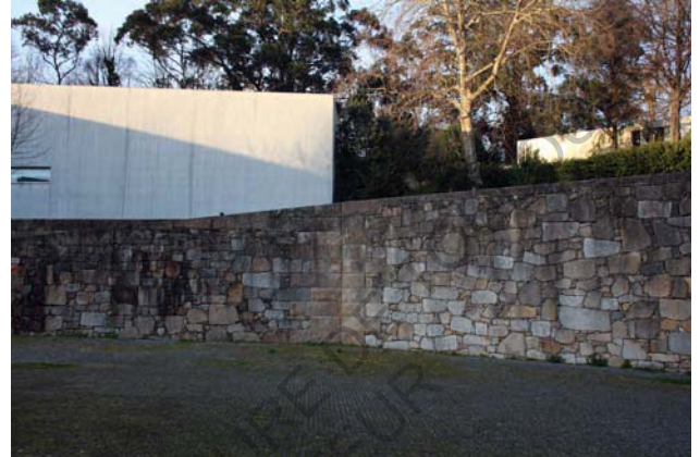
Enduit et granit
