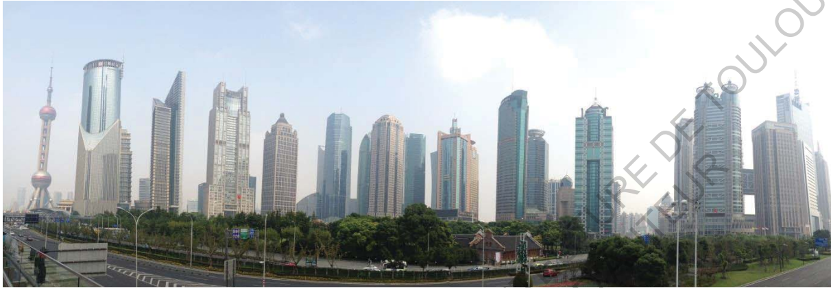
Figure 17 : Vue panoramique au cœur du quartier Pudong, 2014 , Kevin Viel
