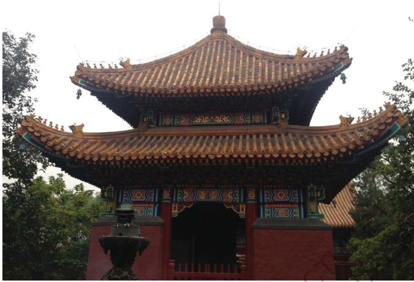
Figure 7 : Toiture du temple Lama , Pékin, 2013, Kevin Viel
