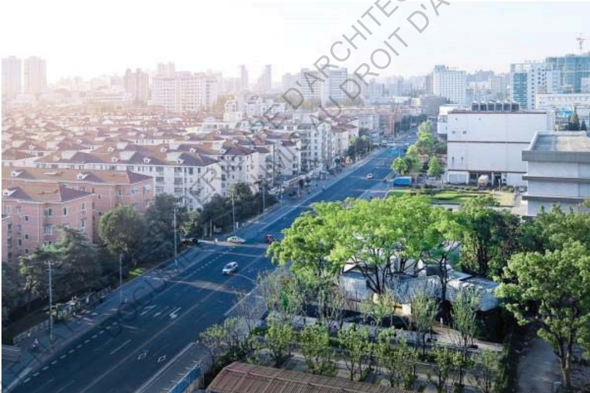
Figure 21 : Le projet dans son environnement urbain , source SAO architecture
