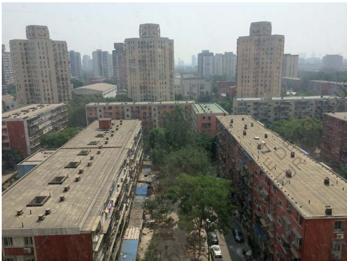
Figure 15 : Vue depuis une unité résidentielle , 2014, Kevin Viel
