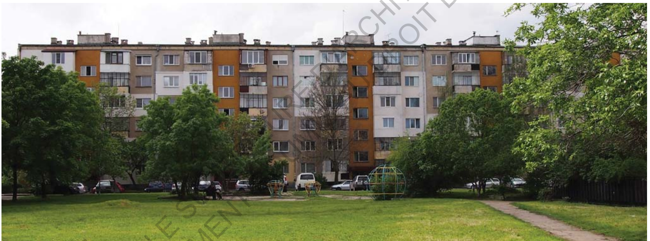
Figure 30 : Homogénéité des cages d'escalier du bloc 45 (Lieu signifiant n° 2) (C.FICAT)
