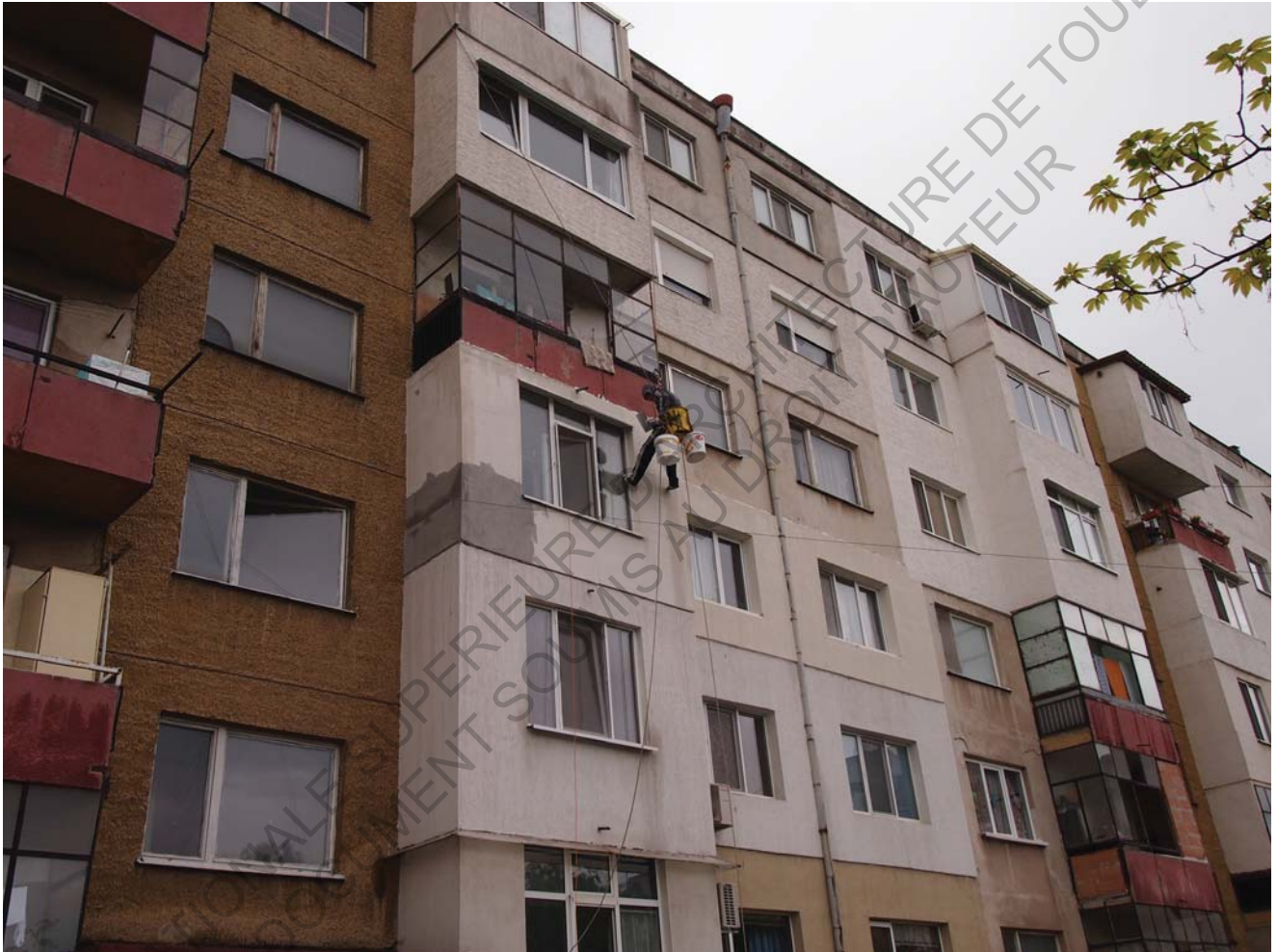
Figure 28 : Une façade d'immeuble partiellement rénovée à l'initiative d'un groupe d'habitants (Drujba 1) (C.FICAT)
