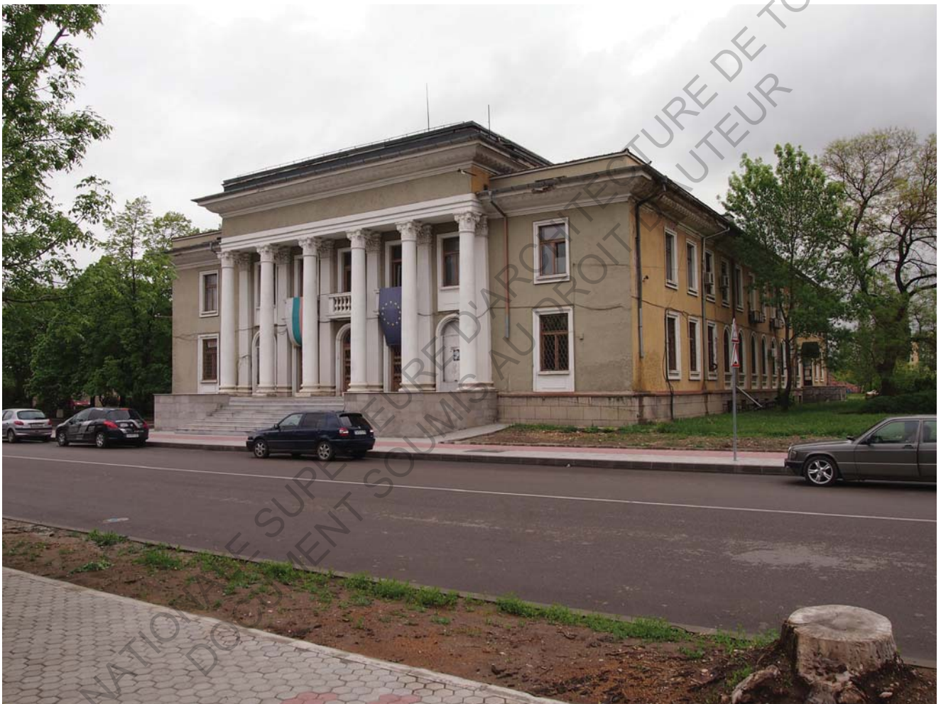
Figure 26 : Photographie de la Maison de la Culture ou Chitalishtë de Drujba 1 (façade côté rue) (C.FICAT)
