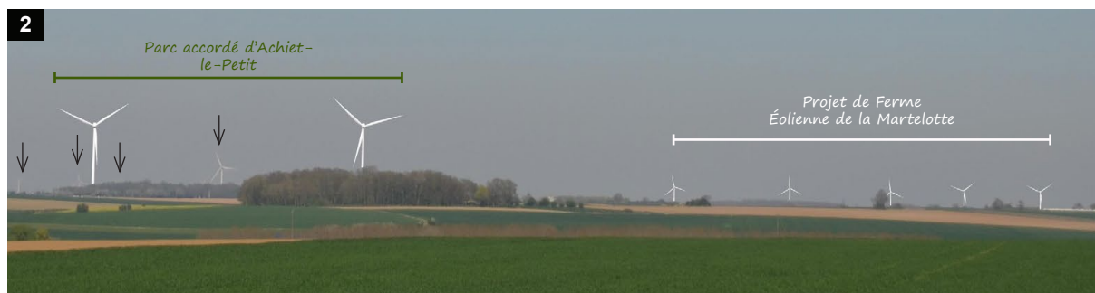
Figure 32 : Photomontage en «vue réelle» depuis la D107 entre Courcelette et Miraumont. Source : EnvirEnE
